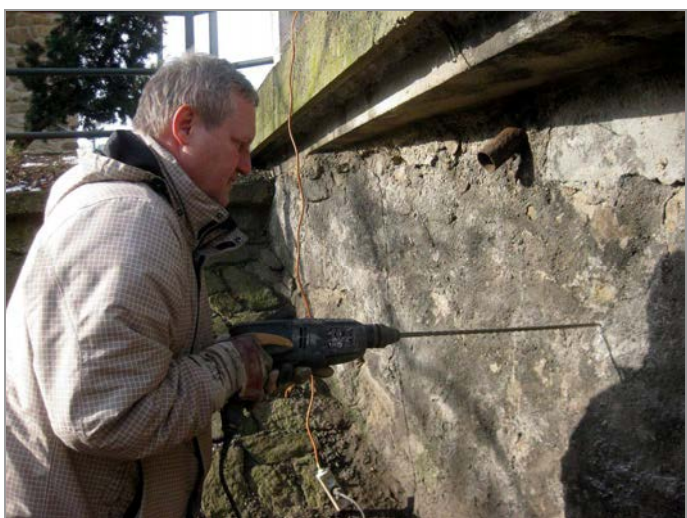
foto 18: Ověřování tloušťky kamenného zdiva čela mostu
