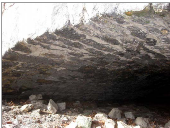
foto 17: Hrubé kamenné řádkové zdivo klenby jižní části mostu
