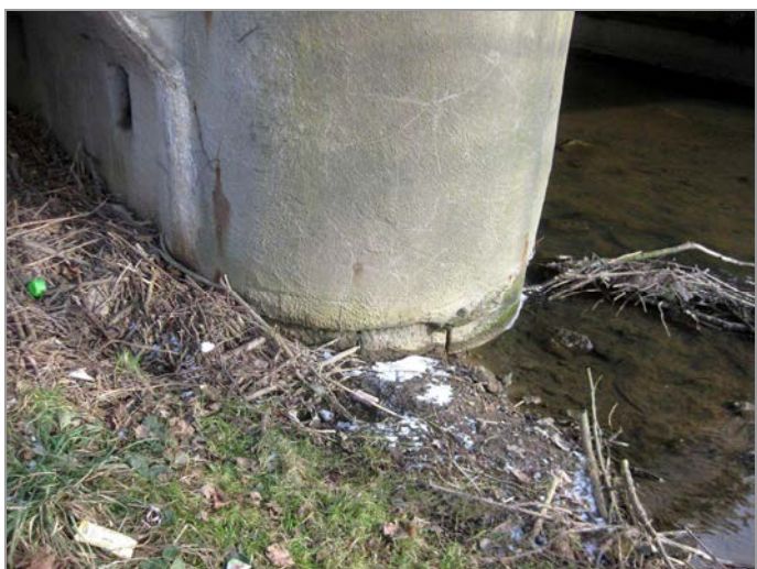
foto 10: Pata pilíře - kamenné zdivo s betonovým nástřikem
