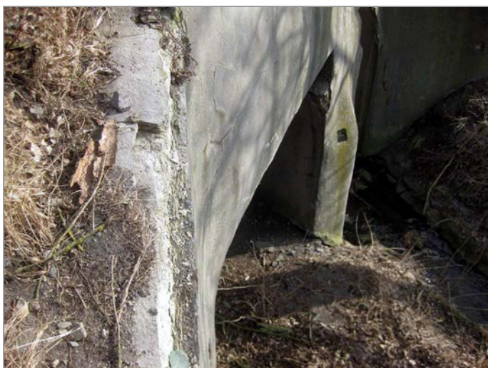
foto 5: Poškozené kamenné zdivo původní části mostu
