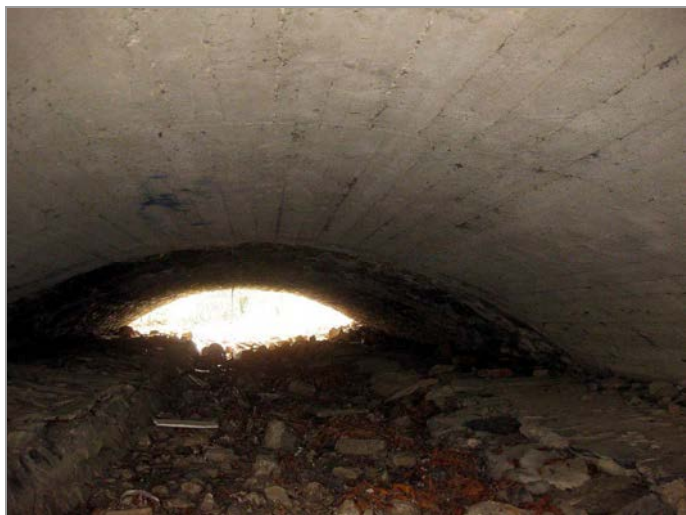
foto 21, 22: Pohled od jihu - ŽB klenba mostu a ověřování její tloušťky
