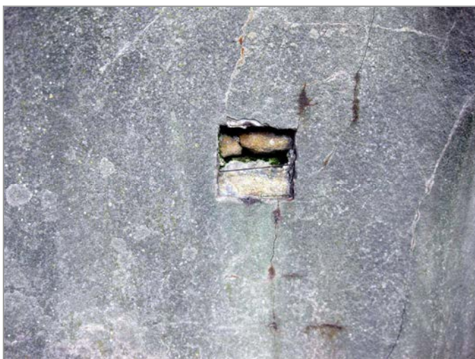
foto 3, 4: Detail původní (západní) část mostu - kamenné zdivo s betonovým nástřikem
