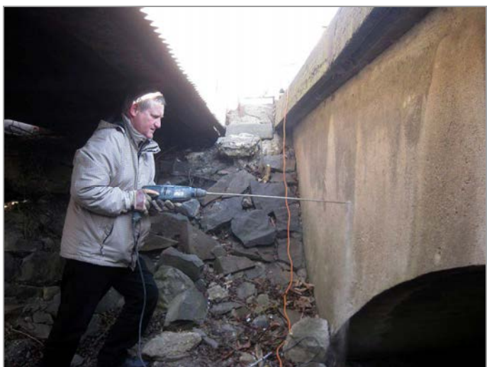
foto 20: Ověřování tloušťky ŽB čela mostu
